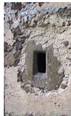
Slika 40: Kamniti okenski okvir, izdelan iz enega kosa kamna. (Foto G. Kolšek)
